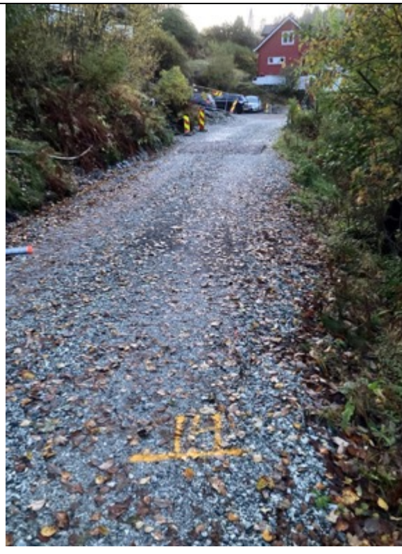
14km, ved elv i rør under veien
